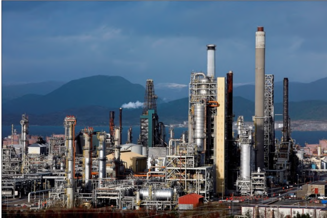
Oljeraffineriet på Mongstad er det største i Norge. I tilknytning til raffineriet finst eit avansert testsenter for karbonfangst og lagring (TCM). Bilete: Bergens Tidende.
